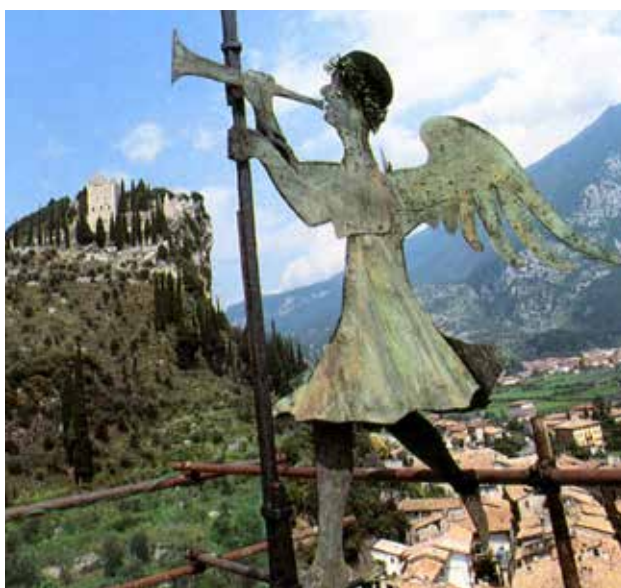
Primo piano dell'angelo sulla punta del campanile della Collegiata di Arco, quando ancora erano in opera le impalcature per i lavori di restauro.
